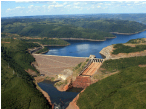
Vista aérea da UHE Barra Grande (RS/SC, 708 MW) Crédito: Divulgação Baesa
