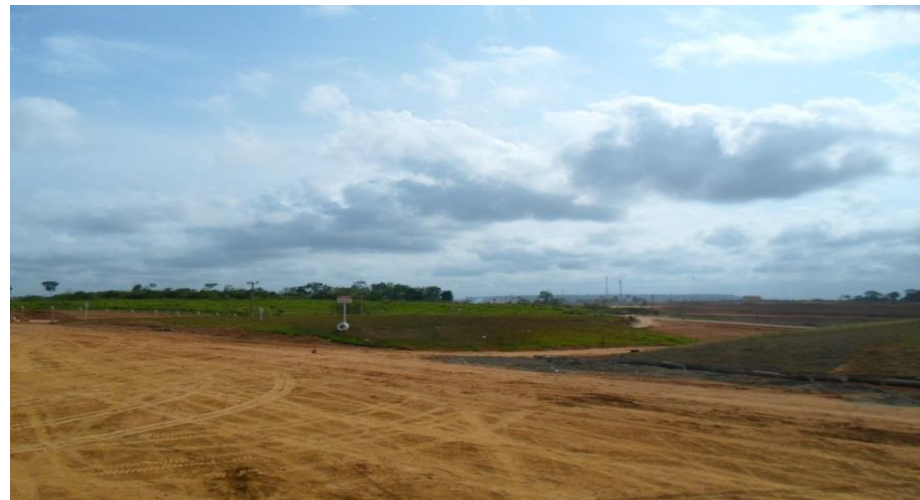
Remediação do lixão - Mar/2013
