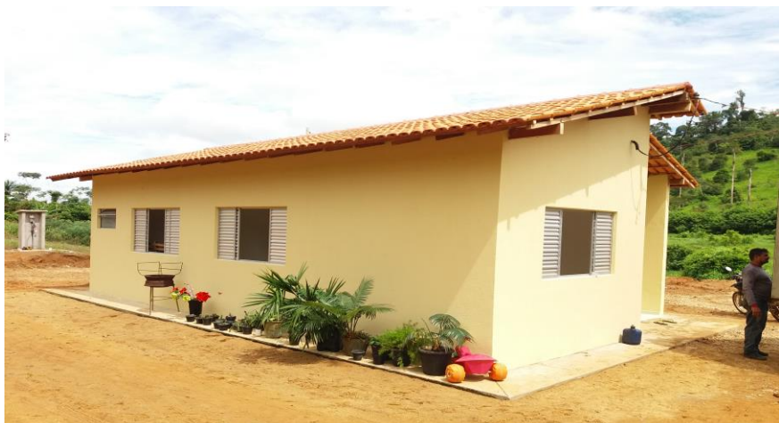
Reassentamento Individual em Área Remanescente - RAR
